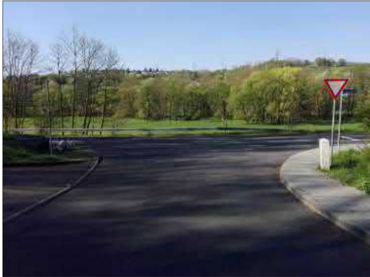
Bild 1: Eppsteiner Straße / Bezirksstraße L 3026 (KP-3), Blick auf Bezirksstraße (Südwesten)
