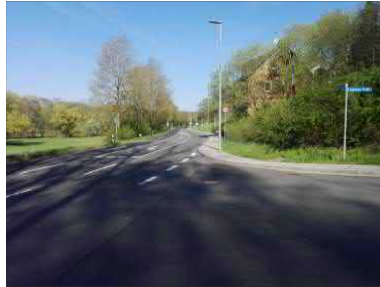
Bild 2: Eppsteiner Straße / Bezirksstraße L 3026 (KP-3), Blick auf Bezirksstraße (Westen)
