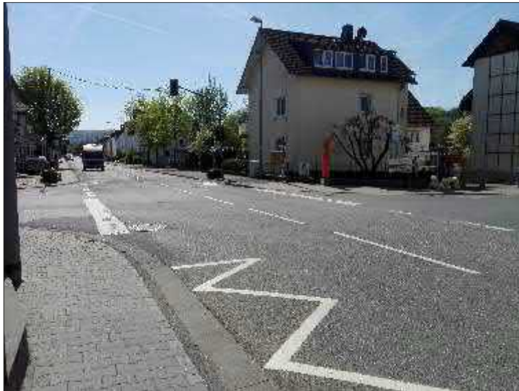
Bild 65: Bezirksstraße L 3026 (KP-1), Blick in Richtung Bezirksstraße (Südosten)
