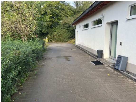
Pflaster vor dem nördlichen Sanitärgebäude
