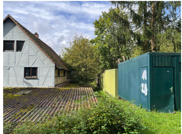
Container neben Wohnhaus.
