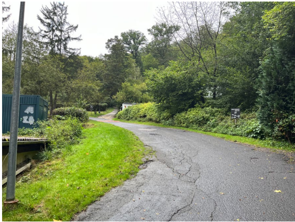
Asphaltierte Zufahrtsstraße, Niederschlagsversickerung an den Seiten.
